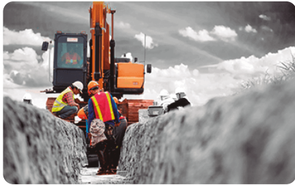
Valas e Escavações
